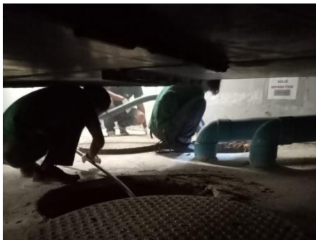
การดูดไขมันบ่อบำบัดน้ำเสีย รูปที่ 2.1-5 ระบบบำบัดน้ำเสียและสิ่งปฏิกูล (ต่อ)
