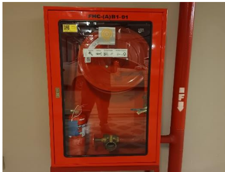
ตู้ FHC และป้ายแสดงวิธีการใช้อุปกรณ์ดับเพลิง
