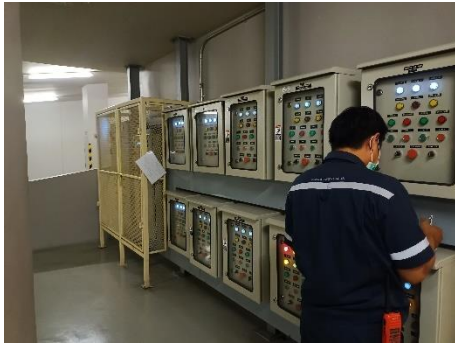
รูปที่ 2.1-7 เจ้าหน้าที่ตรวจสอบเช็คระบบสูบน้ำประปา
